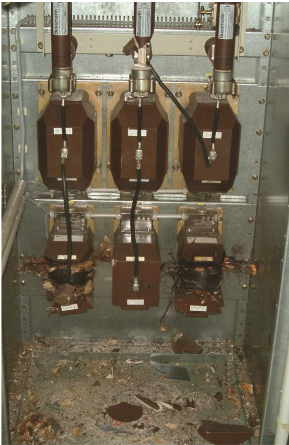
Bild 3: Zerstörte Wandler durch ungedämpfte Schwingungen im Netz
