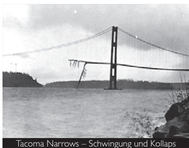
Tacoma Narrows – Schwingung und Kollaps
