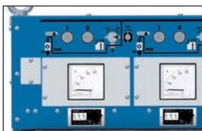
Diverse Messgeräte wie beispielsweise Ampèremeter können ebenfalls direkt in die Bedienfront integriert werden.
