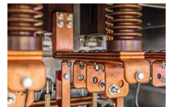
■ Aufwendig verarbeiteter Kabelanschluss.
