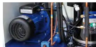
Standard Pumpe P3 (3 barg); optional P5 Pumpe (5 barg). Auch erhältlich als Doppelpumpen P3+P3, P5+P5 (1x stand-by).
