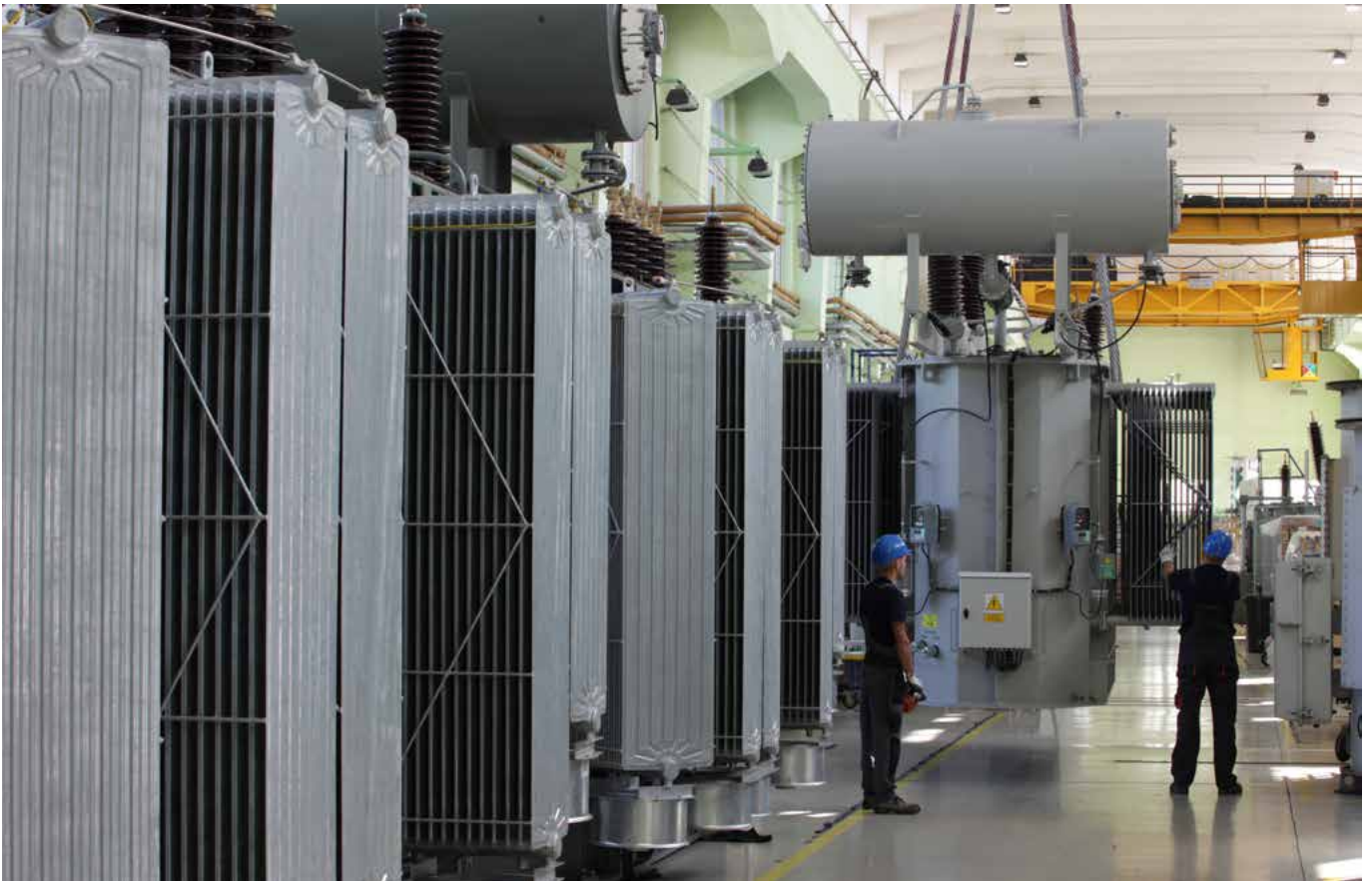
Unsere Fabrik für Leistungstransformatoren
