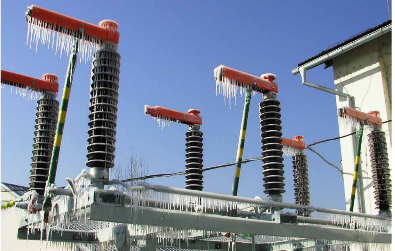
123 kV Trennschalter mit Erdungsschalter während des Vereisungstests
