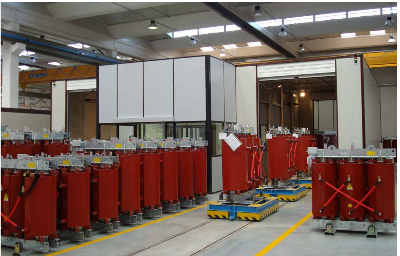
Prüffeld der Gießharztransformatoren
