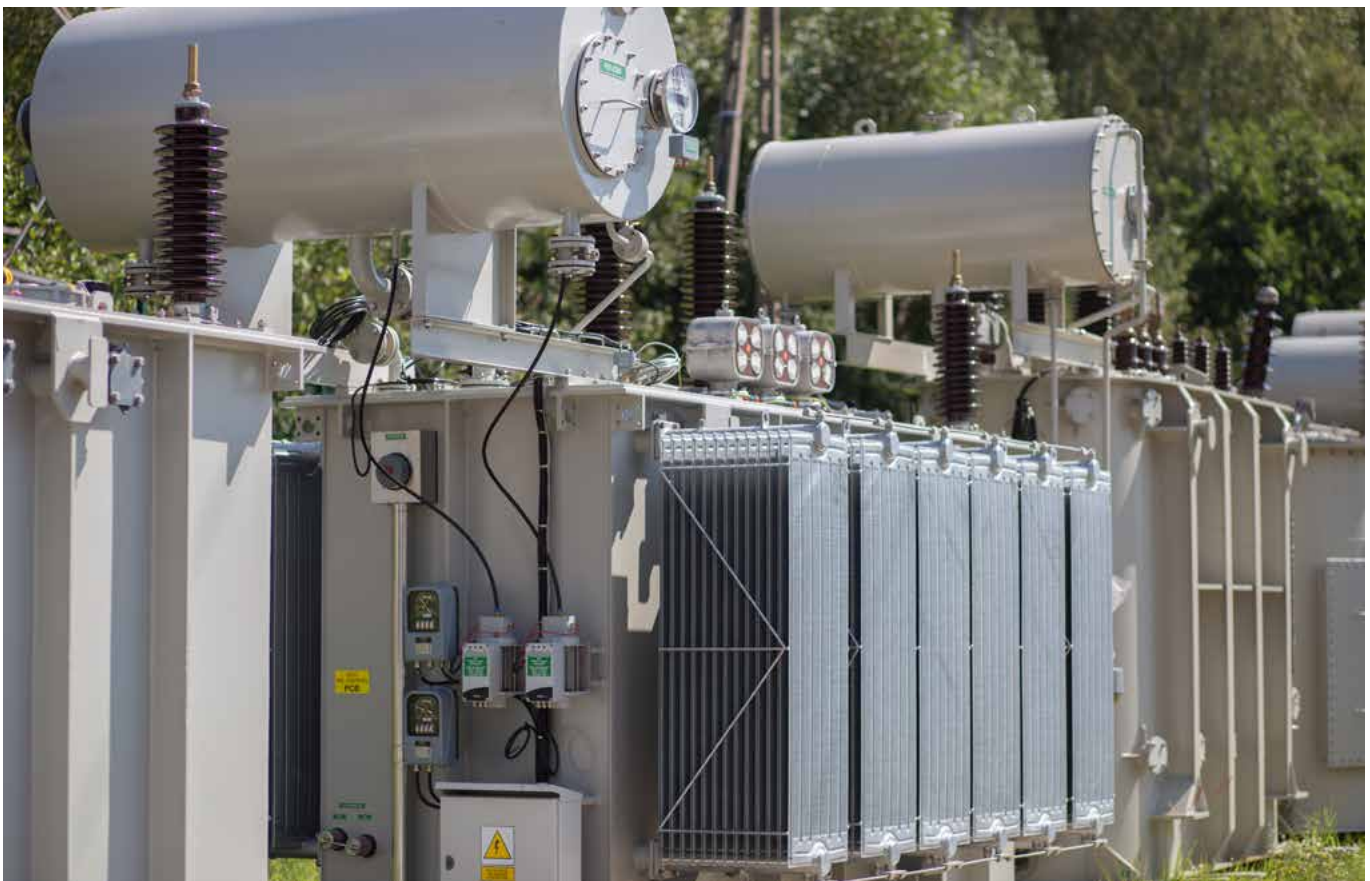
Leistungstransformatoren warten auf den Transport
