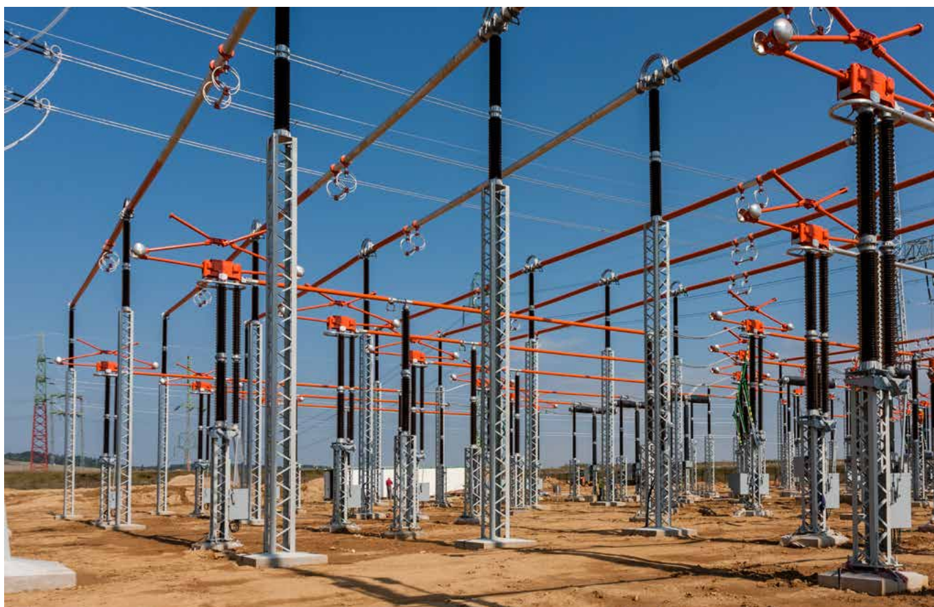
Pantograph Trennschalter installiert in einem 420kV Umspannwerk
