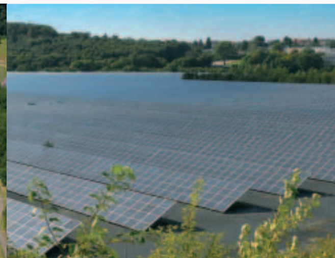
Une des plus grandes installations photovoltaïques du monde / Eine der größten Photovoltaikanlagen weltweit / One of the largest photovoltaic plants in the world
