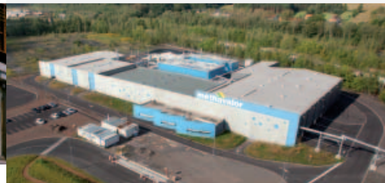
Production de biogaz dans une usine de Méthanisation / Production von Biogas in einer Biogasanlage / Biogas production at a methane plant
