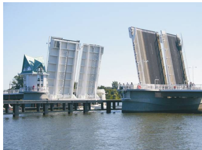
Hydraulisch betriebene Klappbrücke
