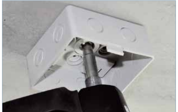
Einfache Montage an Wänden oder Decken mithilfe von Nagelpistolen oder Dübeln
