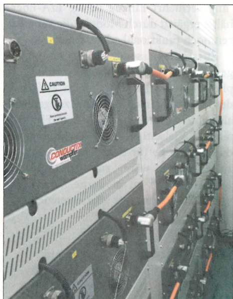
Das Herzstück des Power Packs sind Lithium-Ionen-Akkus der neuesten Technologie in Kombination mit einem speziellen Batteriemanagementsystem.
