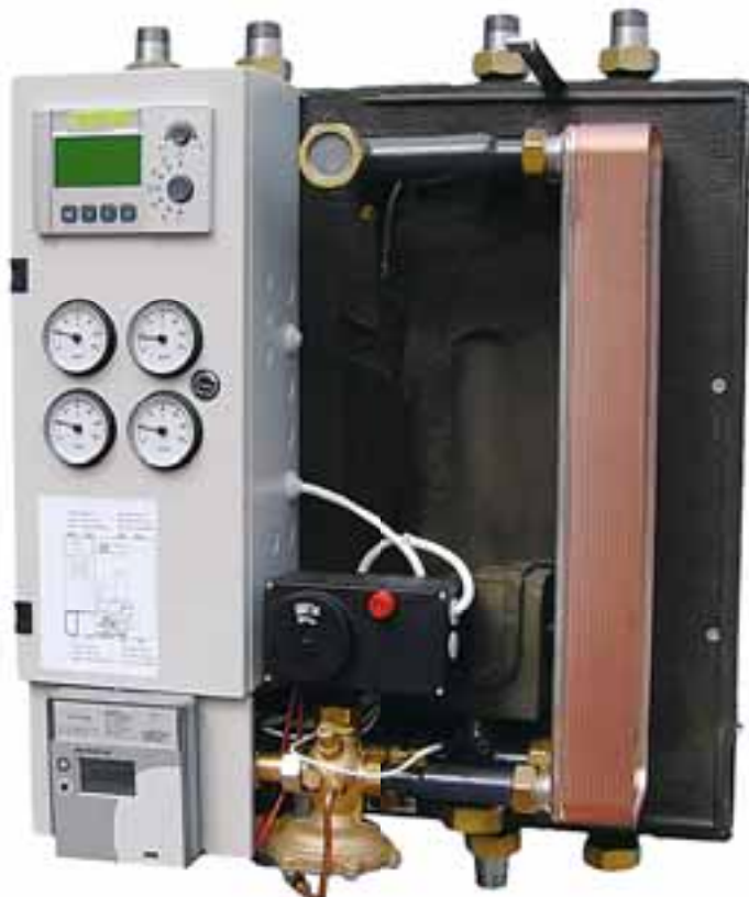
Übergabestation ohne Verkleidung
