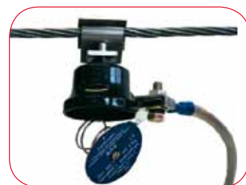
ASA surge arrester with disconnector after MO-blocks have been damaged Überspannungsableiter Typ ASA mit einer Trennvorrichtung nach dem Auslösen (beschädigter Varistor)
