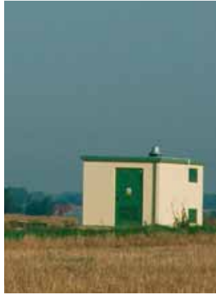
15/0,4 kV transformer station Trafostation 15/0,4 kV
