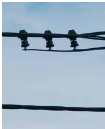
Main line 1 set of ASA every 500 m Hauptfreileitung Satz der ASA je 500 m
