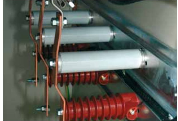
ASW in feeder bay of the transformer station Überspannungsableiter Typ ASW als Sicherung der Leitung innerhalb der Station
