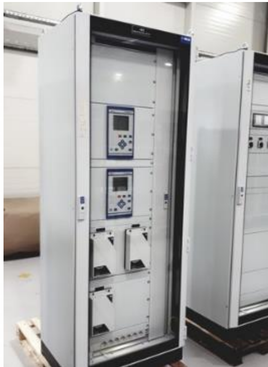
SCHUTZ UND STEUERSCHRÄNKE
