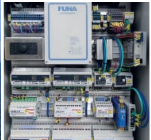
Links: Norwegian Joy (Meyer Werft) Oben: Mit an Bord: Highlights, wie das großzügige Casino (Meyer Werft) Unten: Blick in einen der zahlreichen Steuer-schränke mit LÜTZE-Verdrahtungssystem (Funa).
