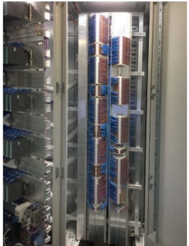
Beispiel eines überarbeiteten Schaltschranks mit dem LSC-System als Einschubvariante mit vertikalem Klemmenaufbau. Quasi zwei Verdrahtungsebenen in einem Schrank (Abb.:LÜTZE)
