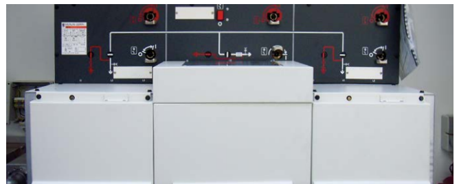
1986 | Einführung der SF6 Schaltanlagen Technik im Mittelspannungsbereich
