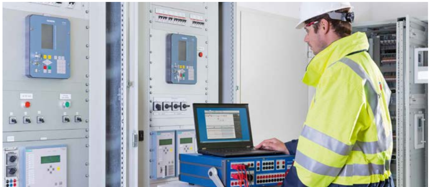
CMC 850 Schutzprüfgerät speziell für IEC 61850-Umgebungen
