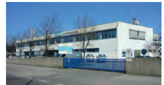
Foto: BAUER KOMPRESSOREN GmbH
