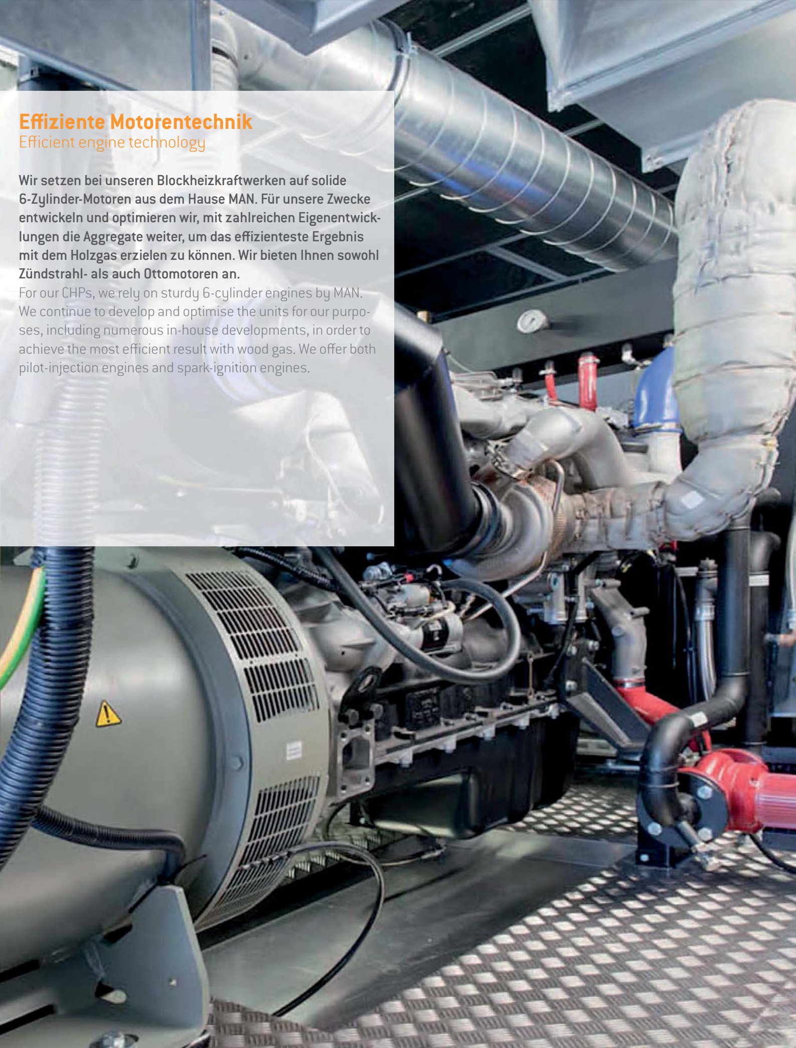
Blockheizkraftwerk auf verwindungsteifem Stahlrohrrahmen. Combined heat and power plant on torsionally rigid tubular steel frame.
