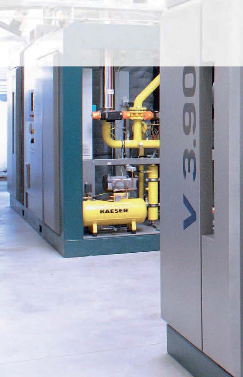
„Zwillingsanlage“ in Meran, Südtirol mit insgesamt 360 kW el und 540 kW th. “Twin plant” in Merano, South Tyrol, with a total of 60 kWel and 540 kWth.
