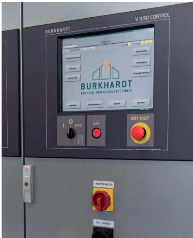
Bedieneinheit und Gasanalyse des Holzvergasers. Control unit and gas analysis of the wood gasifier.
