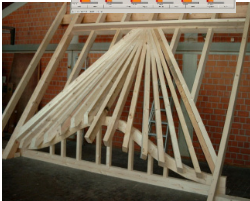
cadwork for the education at the timber framers school Bundesbildungszentrum des Zimmerer- und Ausbaugewerbes Kassel/Germany : Dormer, cut on Hundegger K2+
