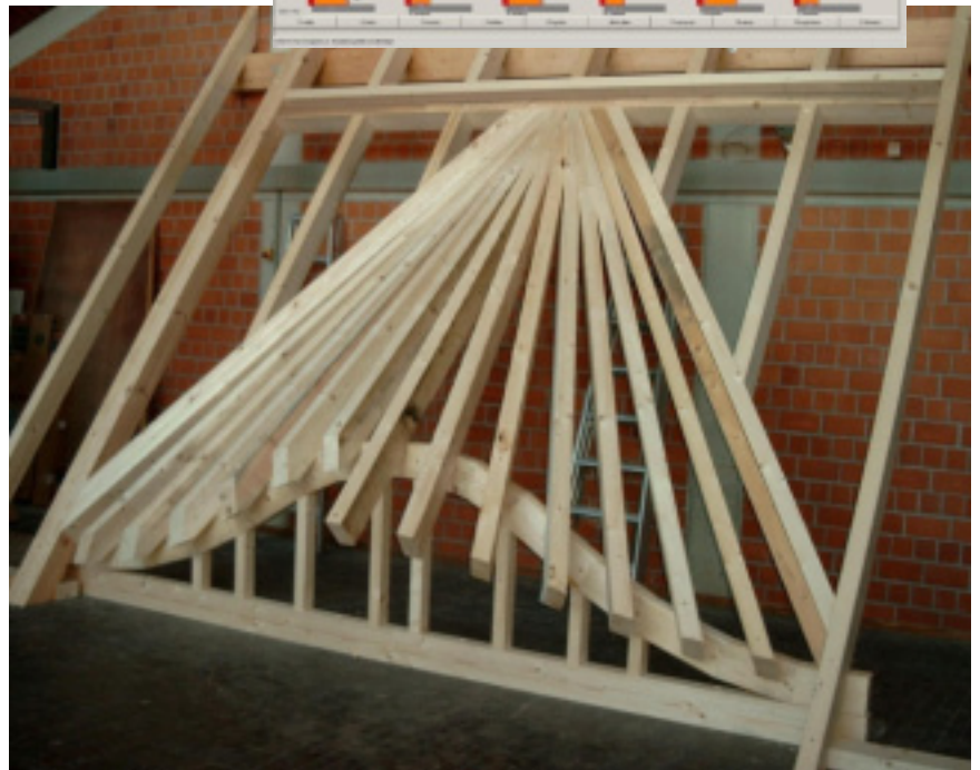
cadwork in der Ausbildung am Bundesbildungszentrum des Zimmerer- und Ausbaugewerbes in Kassel: Fledermausgaube, abgebunden auf einer Hundegger K2+
