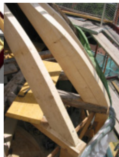
Schlosskirche Haigerloch Holzbau Ott, Gammertingen
