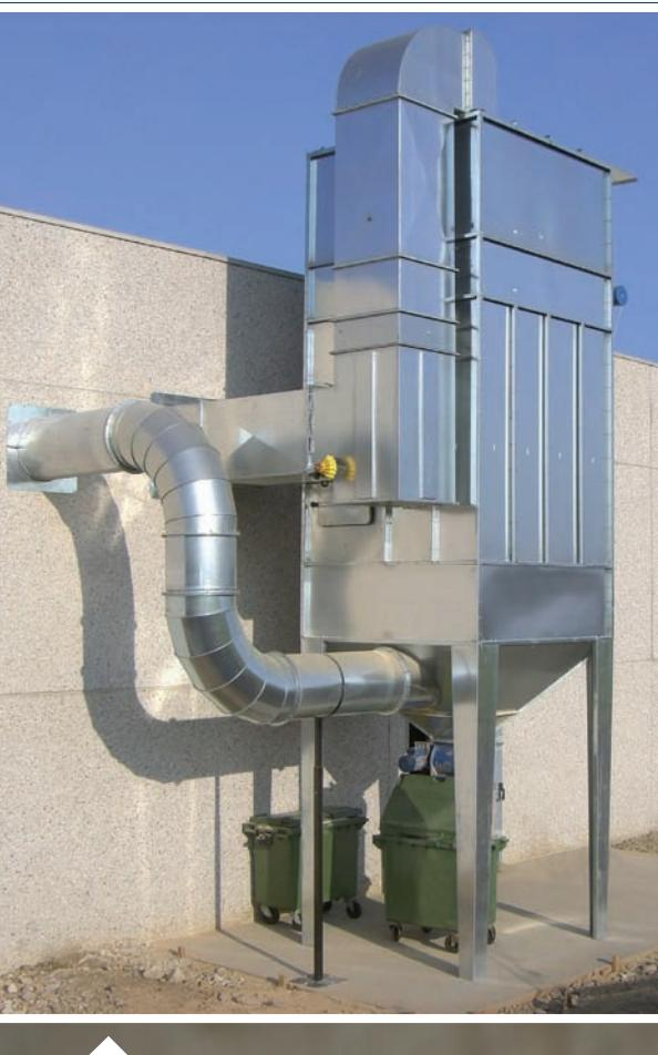
Esempio di **AIRCOM/L** con Tubazione a T per reintegro dell'aria in ambiente con BY-PASS motorizzato e sonda polveri Tribo-Check.
