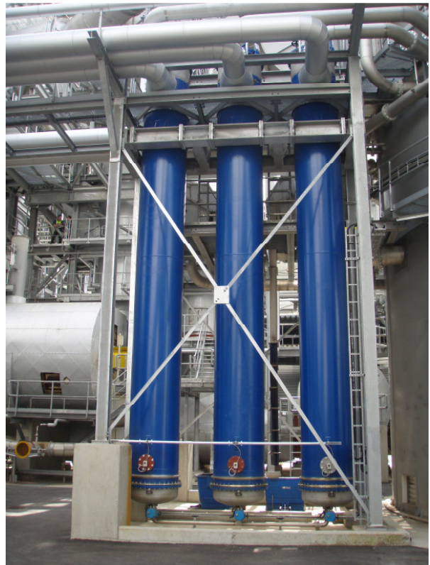
Wasser-/Wasser-Wärmetauscher 3 x 4 MW • 72 °C Einspeisetemperatur ins Versorgungsnetz
