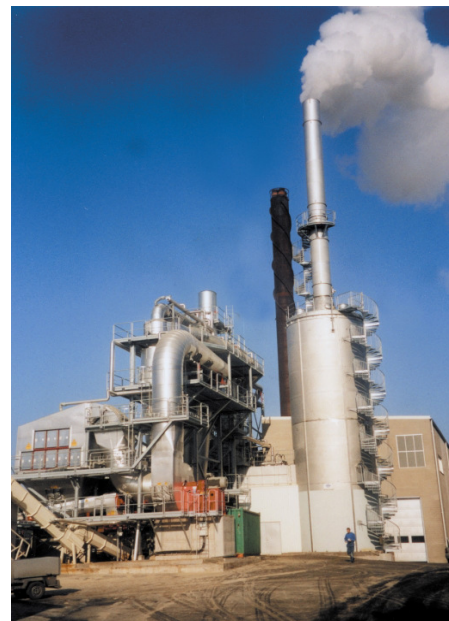
Pellet-Trockner mit Nassabsorber, Nass-Elektrofilter und Wasser-/Wasser-Wärmetauscher
