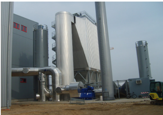
Trockensorption mit Heißluft-Elektrofilter und NO x -Katalysator
