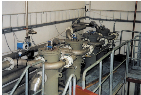
Einfache Inspektion und Wartung der Wärmetauscher durch Vorkammern
