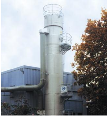
Textilreinigung - Altölf Feuerung; 8000 Bm 3 /h
