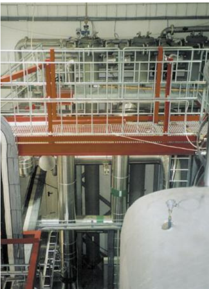
4 MW Wasser/Wasser-WT für Fernheizung mit abnehmbaren Kopfdeckeln
