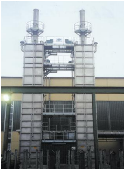
Schmiedepressenabsaugung; 2 x 17.000 Bm 3 /h
