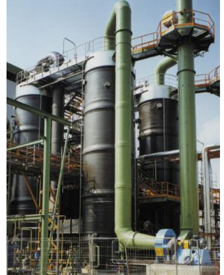
2 parallel geschaltete Doppel-NEF in GFK Abscheidegrad > 99,7%
