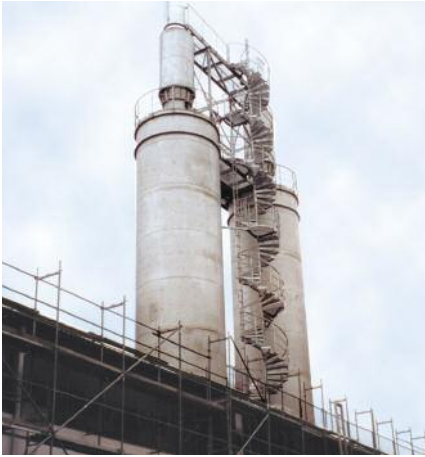
Schmiedepressenabsaugung; 2 x 35.000 Bm 3 /h
