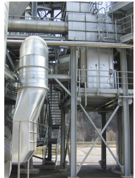
Wasser/Luft-WT für Verbrennungsluftvorwärmung; 71.000 m 3 /h; 1,56 MW
