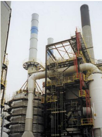
Flüssigabfallverbrennung mit 2 DUAL-NEF; 4 x 118.000 Bm 3 /h
