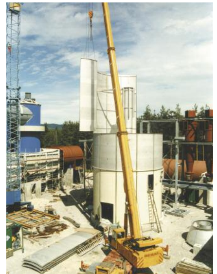
Panel-Elementbauweise in Edelstahl mit am Zentralrohr vormontierten Auflageträgern
