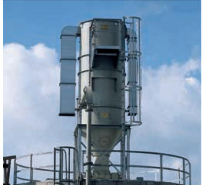
Zyklon-Spülluftfilter mit kontinuierlicher Abreinigung auf Spänebunker als Endfilter für Hochdruckförderleitung.
