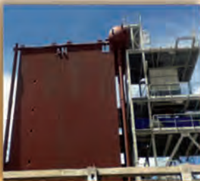
Feuerraum mit Flossenrohrwand
