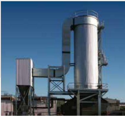
Feststoffbefeuerter Thermalölerhitzer in 3-Zug-Bauweise, Leistung 12 MW, Australien
