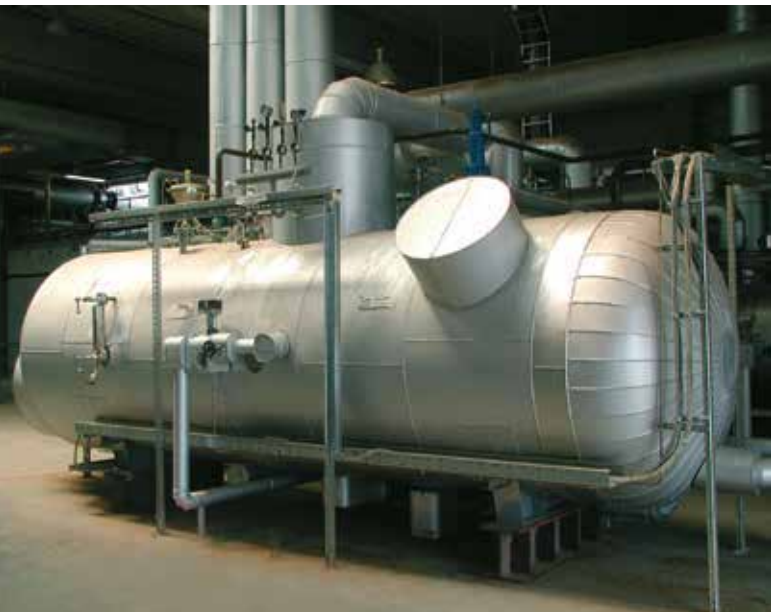
Wärmeträgeröl-beheizter Dampferzeuger für die Erzeugung von 15 t/h Sattedampf, 16 bar, für eine MDF-Anlage in Deutschland
