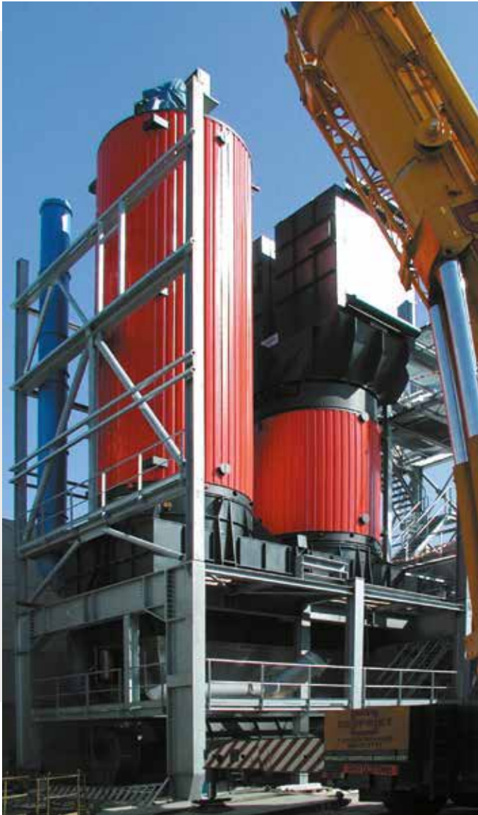
Montage eines Thermalölerhitzers mit aufgesetztem Kombibrenner zur Verfeuerung von Schleifstaub und Erdgas in Belgien
