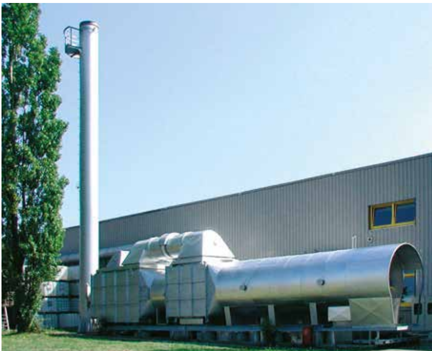
Thermische Abluftreinigungsanlage für 20.000 \text{ Nm}^3/\text{h} lösungsmittel- beladener Abluft
