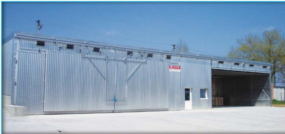
**Wielkości komór.** Najczęściej, zastosowanie znajdują komory objętości od 8 do 120 metrów sześciennych tarcicy. Podstawowe wymiary takie jak: szerokość, głębokość i wysokość stosu drewna poddanego suszeniu są parametrem określającym objętość użyteczną komory.
