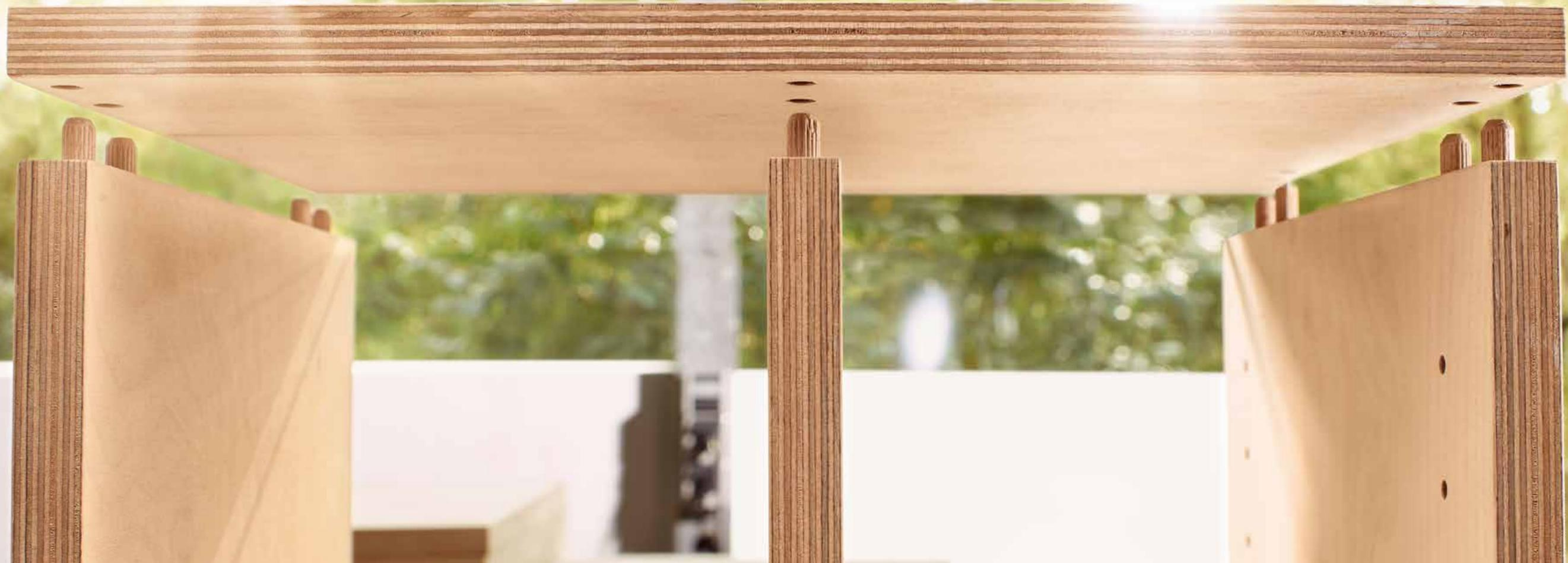
Ob Außenecke, Mittelwand oder Lochreihe: Der DDF 40 ermöglicht nicht nur die Präzision einer Stationärrmaschine, sondern schafft das mit Standard-Rundholzdübeln auch besonders kostengünstig. Außerdem ist dank Doppellochtechnik schon bei der Montage eine extrem hohe Stabilität gewährleistet.
