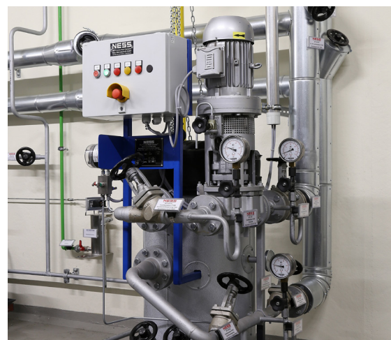
Eingebaute Feinfilterstation FF300
