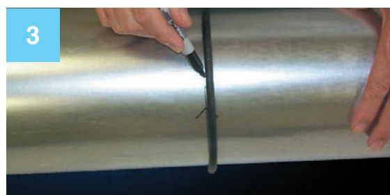
Benutze den O-Ring zum Anzeichnen der Schnittlinie.
