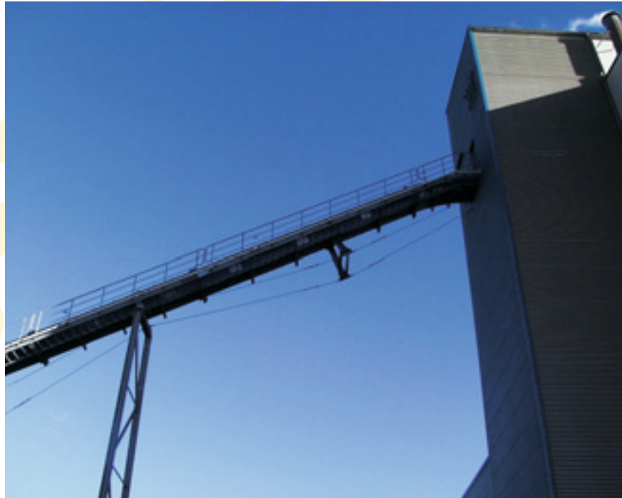
Förder-, Lager- und Dosiereinrichtung für Altholz
