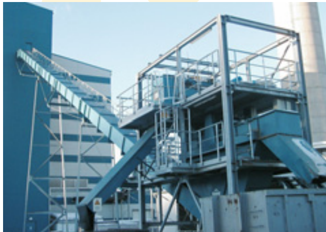
Spezialgurtförderer und Separationstechnik in einer Altholzverbrennungsanlage.
