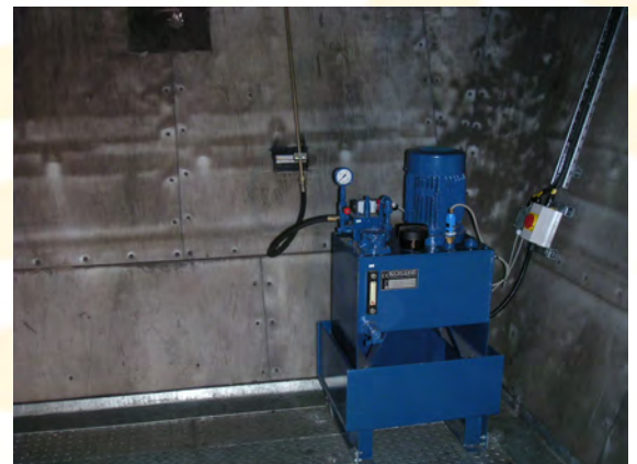
Hydraulikaggregat für den Rotorarmantrieb
