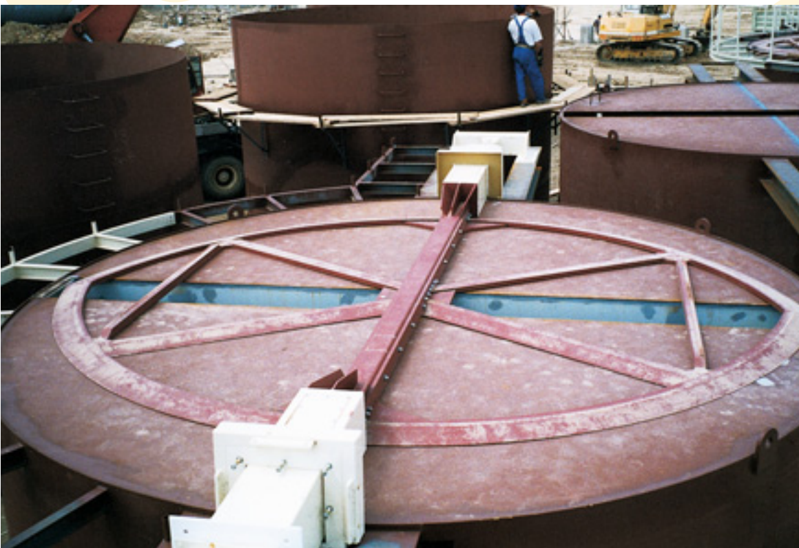
Montage eines Tandem-Gleitrahmens, Ø 6000 mm, während der Silofertigung.
