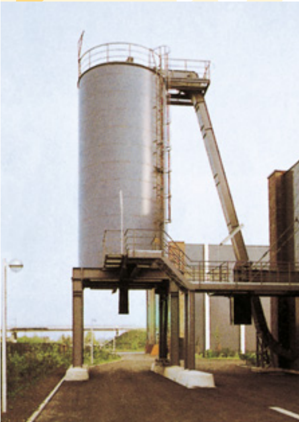
Silo mit Gleitrahmen zur LKW-Beladung
