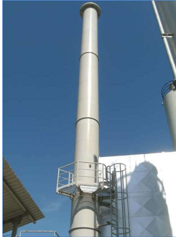
Unsere Stahlkamine und Lüftungstürme werden entsprechend den jeweiligen technischen Anforderungen zur Abführung von Abgasen und Abluft nach DIN EN 13084-7 ausgelegt, konstruiert, gefertigt und montiert. Die Außengestaltung erfolgt nach Ihren wirtschaftlichen und architektonischen Wünschen sowie nach statischen Gesichtspunkten. Die Kennzeichnung des Produkts erfolgt gemäß der CE-Richtlinie. Umfassende qualitätssichernde Maßnahmen stellen sicher, dass Ihre Anlagen höchste Standards erfüllen.
