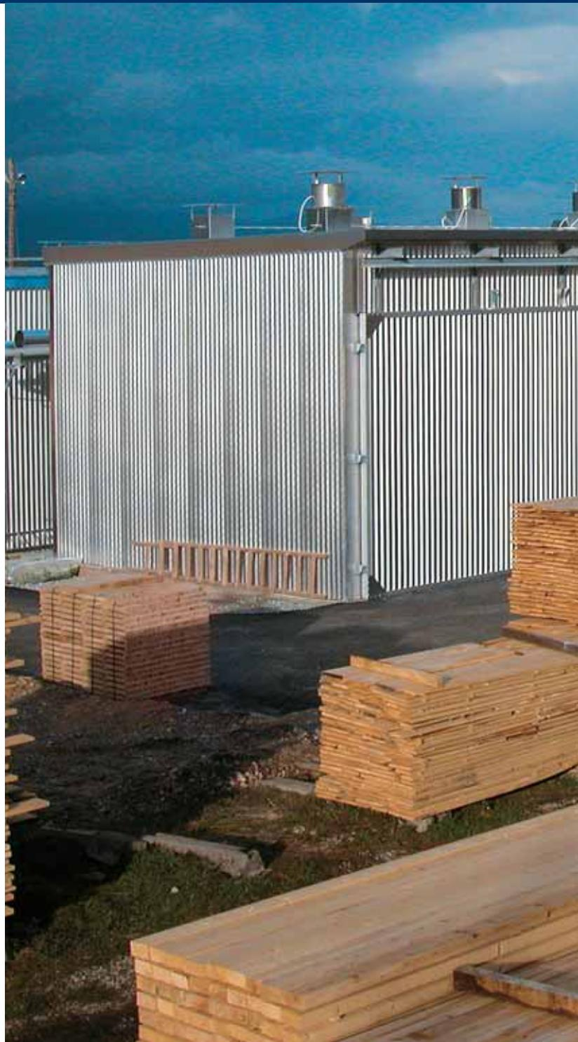
минеральной ваты, просмоленной и непромокаемой (пропитанной) для получения повышенной изолирующей способности, как термический, так и акустической. Технология SECAL предусматривает специальный горизонтальный профиль с двойным уплотнением для избежания термических мостов. Такие профили, расположенные на расстоянии одного метра друг от друга, заметно укрепляют всю структуру и создают поддержку изолирующему материалу. Внешний
