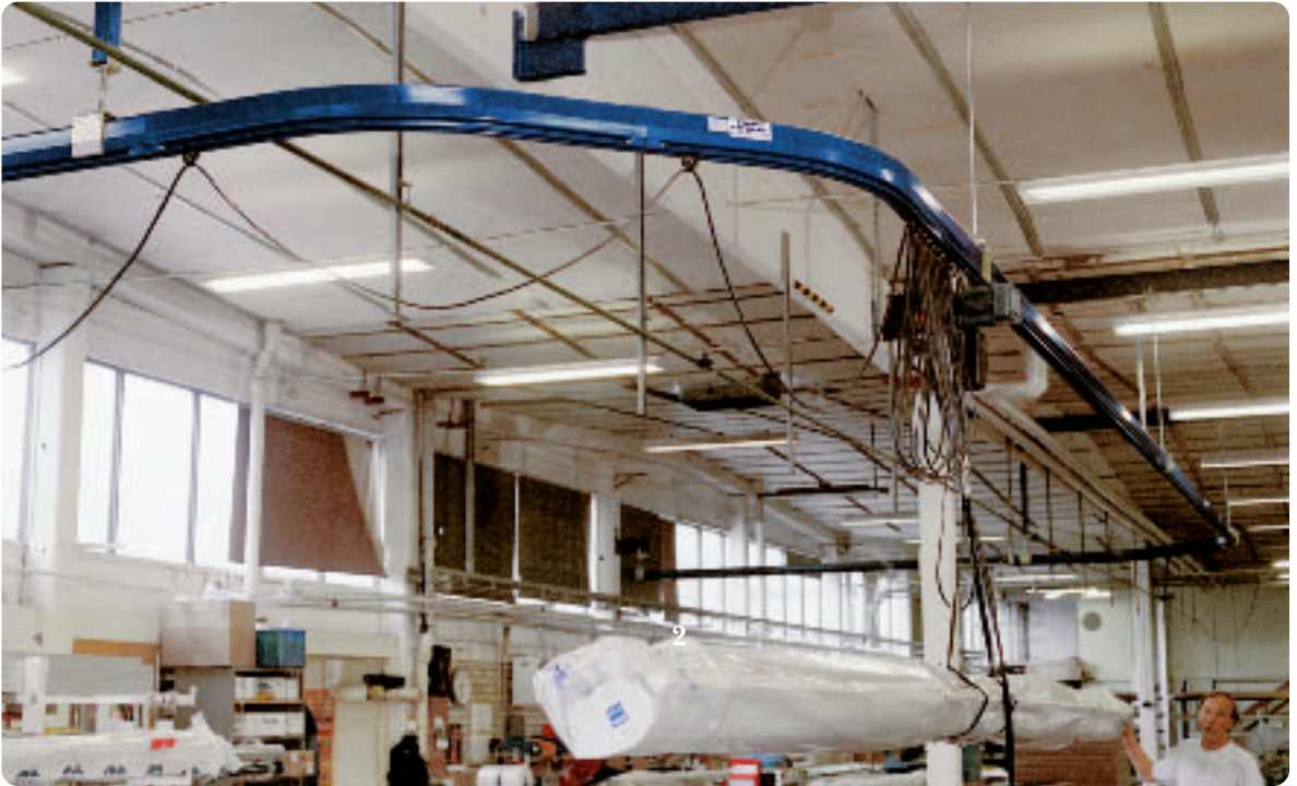
Einschienebahn in der Jalousien-/ Fenstermarkisenindustrie.
