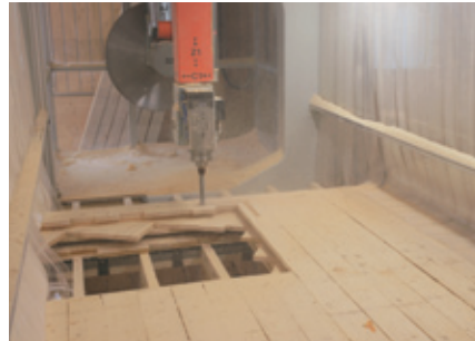
Zuschnitt eines Vollholz-Elements la coupe de l'élément en bois massif the pre-cut of a wooden element
