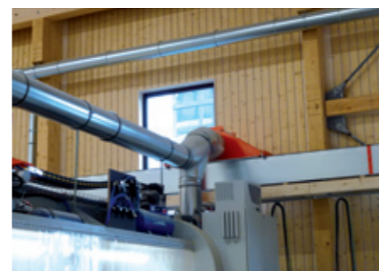
Schwebestaubentsorgung über Kanal aspiration micropoussières par canaux suspended dust disposal via duct
