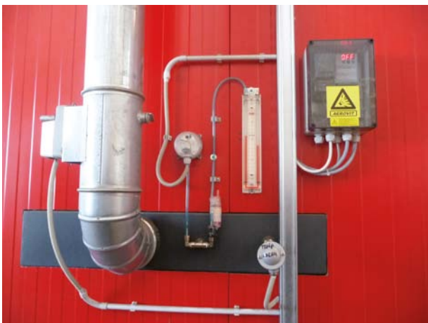
Sistema regolazione aria secondaria Secondary air adjustment system Systeme de réglage air secondaire Sistema de regulación aire secundario Regelungssystem der Sekundärluft
