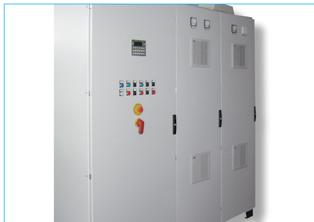
Quadro elettrico di controllo e comando - Control cabinet
