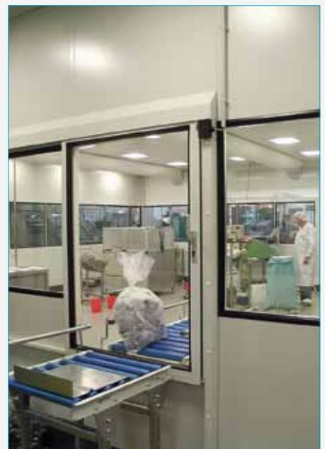
Zuverlässig verpackt: Materialschleusensysteme vom klimatisierten Reinraum bis zur Auslieferung
