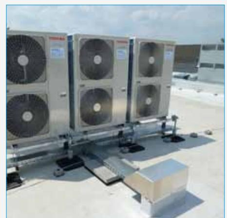
Modulare Klimakonzepte mit redundanter Kälteerzeugung
