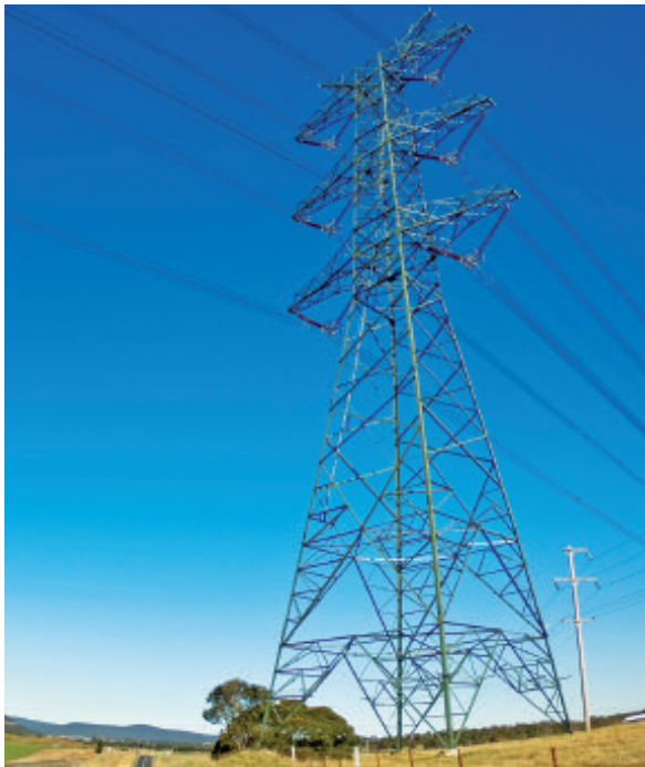
Umweltfreundliches Entlacken eines Strommastes mit cleanLASER
