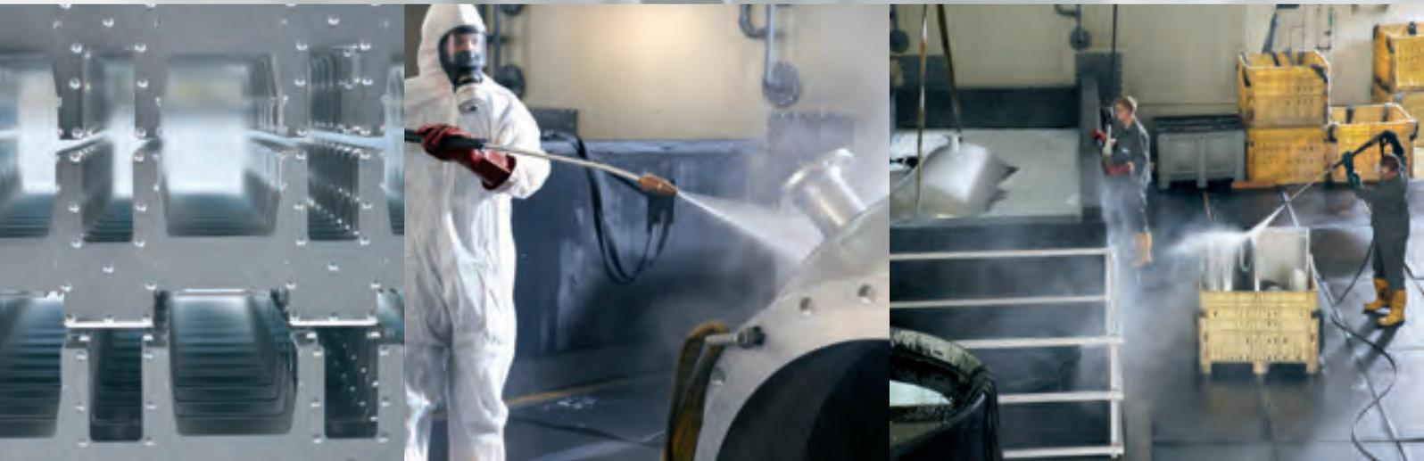
Unsere Spezialität sind Beiz- und Reinigungsarbeiten von Rohrleitungen und Behältern vor Ort, besonders in sensiblen Bereichen von Pharma- oder lebensmittelverarbeitenden Betrieben. Das Reinigen, Elektropolieren und Beizen sind in allen Verfahren auch vor Ort möglich und werden umweltverträglich durchgeführt.
