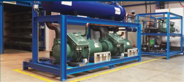
Die Kältemaschine deckt nur den Bedarf des Eloxalbades ab. Glanzbad und Gleichrichter werden über Trockenkühler versorgt.
