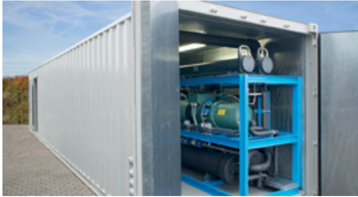
Flexibel und mobil: Reisner-Kälteanlage im Container
