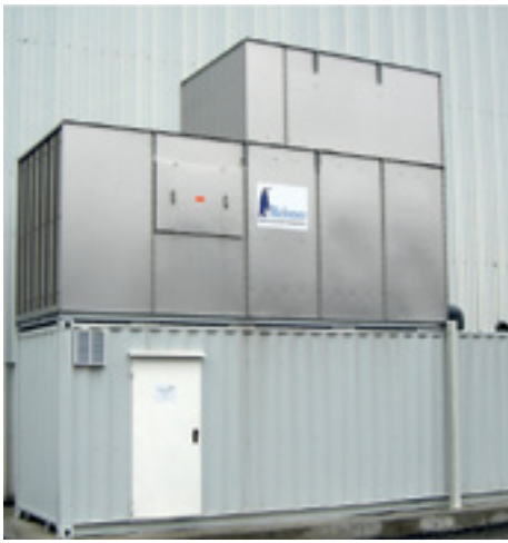
Reisner-Kühlturmanlage – die komplette Wassertechnik ist im Container untergebracht.
