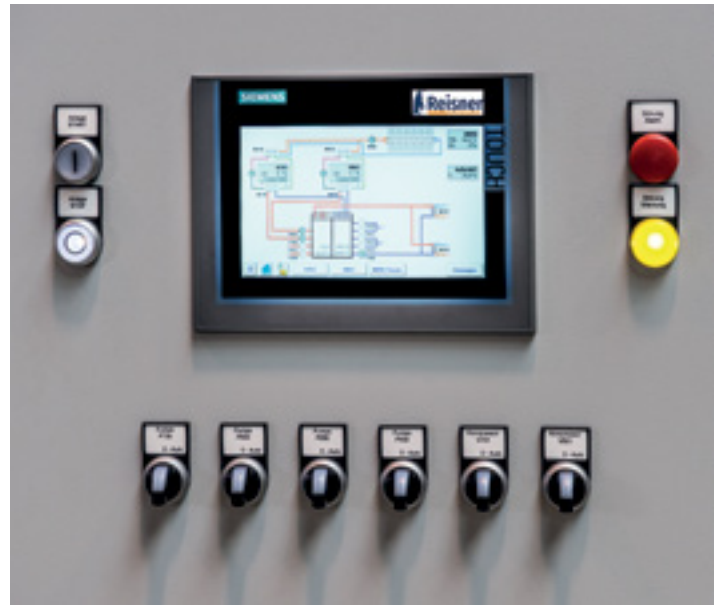
Siemens-SPS für präzise, individuelle Steuerung
