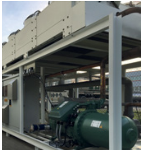
Reisner-Kältemaschine, zur Innen- und Außenaufstellung geeignet, mit aufgebautem Kondensator
